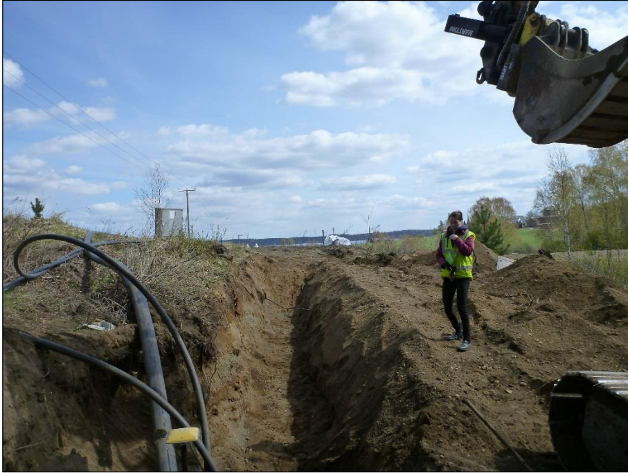
Kaivanto lopullisessa syvyydessä. Taustalla näkyvät muinaisjäännösalueella sijaitsevat kaivo, sekä sähkökeskus, joiden kaapelit risteävät nyt kaivetussa kaivannossa. Kuvattu itään.
